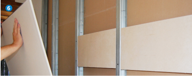
Ansetzen der ersten Plattenlage.
