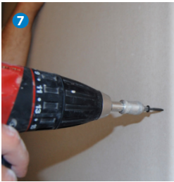
Ansetzen der ersten Plattenlage.
