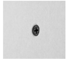
Korrekt eingedrehte Schraube
