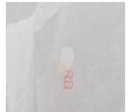
Die Verspachtelung des Schraubenkopfes ist problemlos in einem Arbeitsgang möglich
