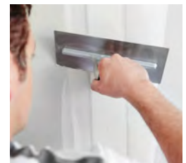
Spachteln ohne Rigips Bewehrungsstreifen
