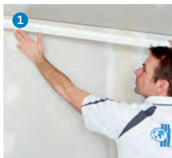
Abschlusskante ausrichten
