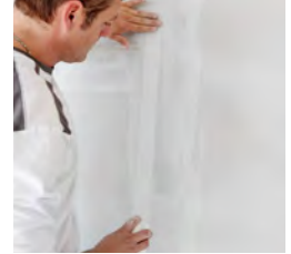
Spachteln mit Rigips Bewehrungsstreifen
