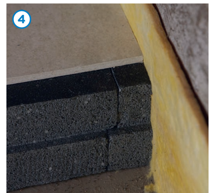
Alternativ kann auch der überstehende EPS-Streifen der letzten Anschlittplatte abgetrennt und an die Wand angelegt werden. Somit lassen sich ganze Elemente einlegen. Wichtig ist, dass eine vollflächige Auflage ohne einen Luftspalt entsteht.
