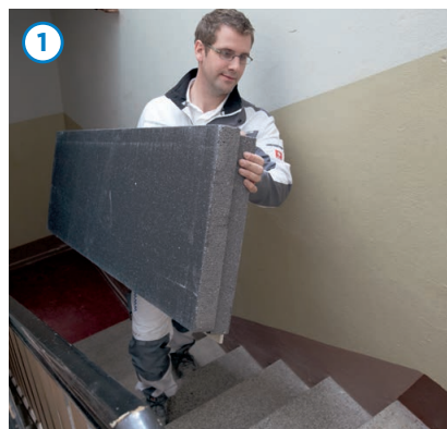
Das Rigidur Dachbodenelement eignet sich aufgrund seiner Abmessung (500 x 1.500 mm) optimal für den Transport durch enge Treppenhäuser und passt durch jede Dachbodenluke.
