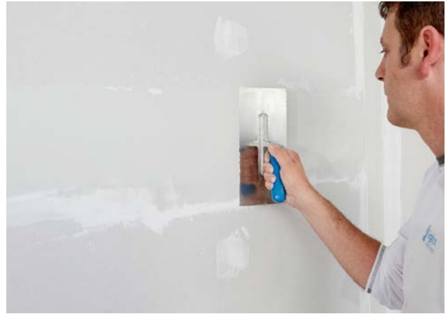
Überziehen des Rigips Glasfaserbewehrungsstreifens ohne zusätzlichen Materialauftrag.
