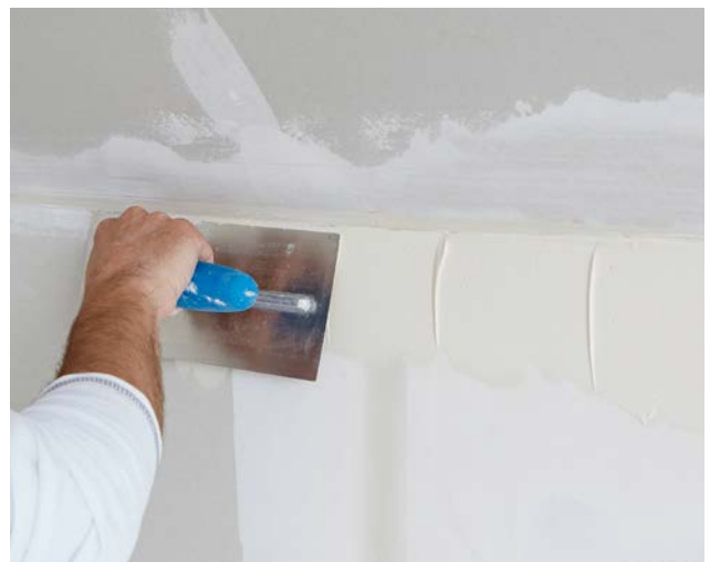
... und Vorlegen des Fugenspachtels.
