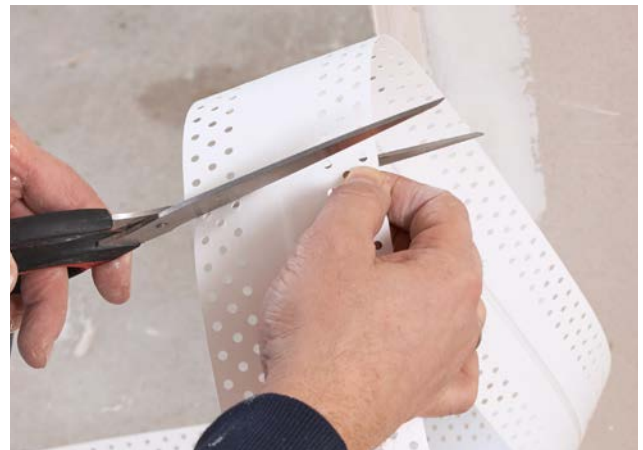
Direktes und schnelles Zuschneiden mit der Schere.
