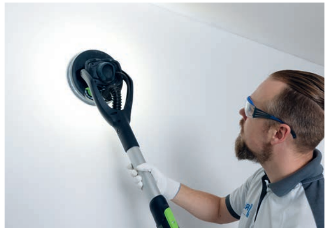
Falls erforderlich, maschinell mit einem 240er- bis 280er Schleifpapier oder manuell mit einem 240er-Schleifpapier abschleifen.
