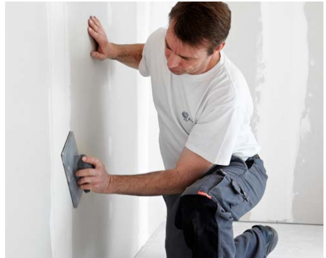
Optische Prüfung der Vorspachtelung sowie Entfernung evtl. vorstehender Spachtelgrate.
