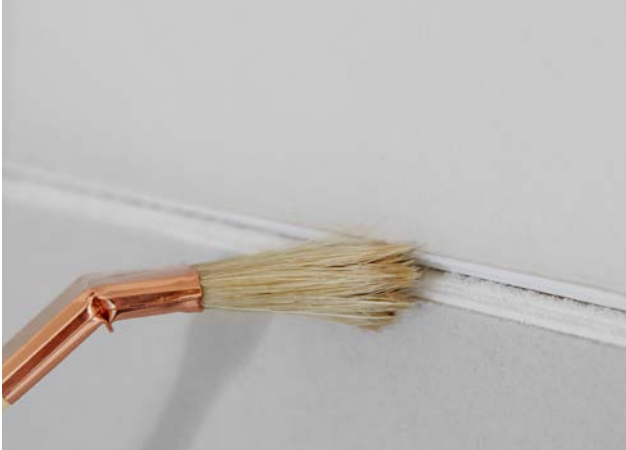
Gipsstaubentfernung für eine gute Haftung!
