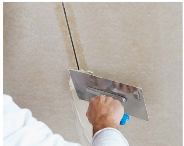
Ausfüllen der Fuge mit VARIO Fugenspachtel. Auf ausreichende Haftung an den Plattenkanten achten.
