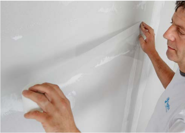
... und unmittelbares Einlegen des Rigips Glasfaserbewehrungsstreifens.
