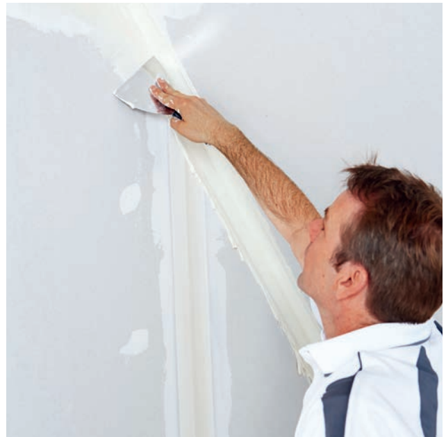
Mit dem Abziehen der überstehenden Spachtelmasse ist die Ecksituation mit dem Rigips Levelline fertiggestellt.
