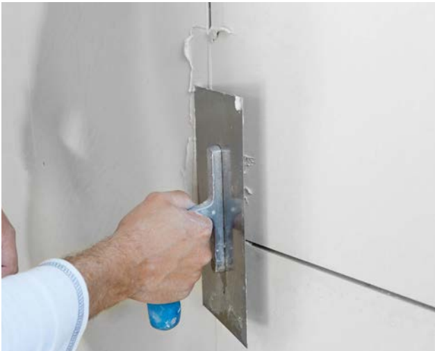
Ausdrücken der Querfugen mit VARIO Fugenspachtel, ...
