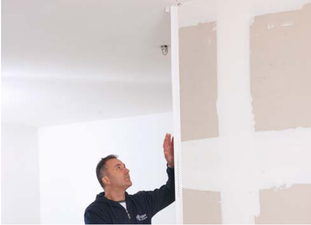
Ansetzen des AquaBead Flex PRO und Andrücken per Hand von oben nach unten.
