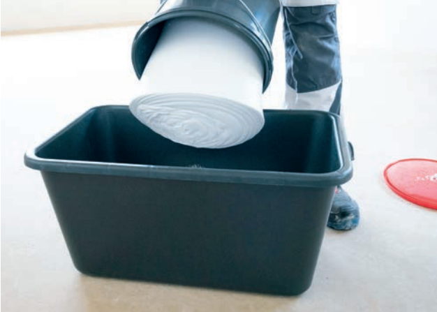
Den ProMix Airless einfach wie eine Teigkugel in eine Mörtelwanne kippen
