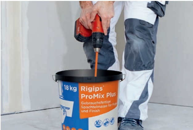
Unter Zugabe von ca. 100 ml Wasser pro 5 kg Spachtelmasse wird der ProMix Plus gut durchgerührt ...
