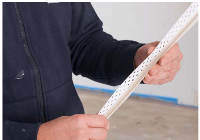
Flexibles Vorformen des Rigips AquaBead Flex PRO für die gewünschte Eckausbildung.
