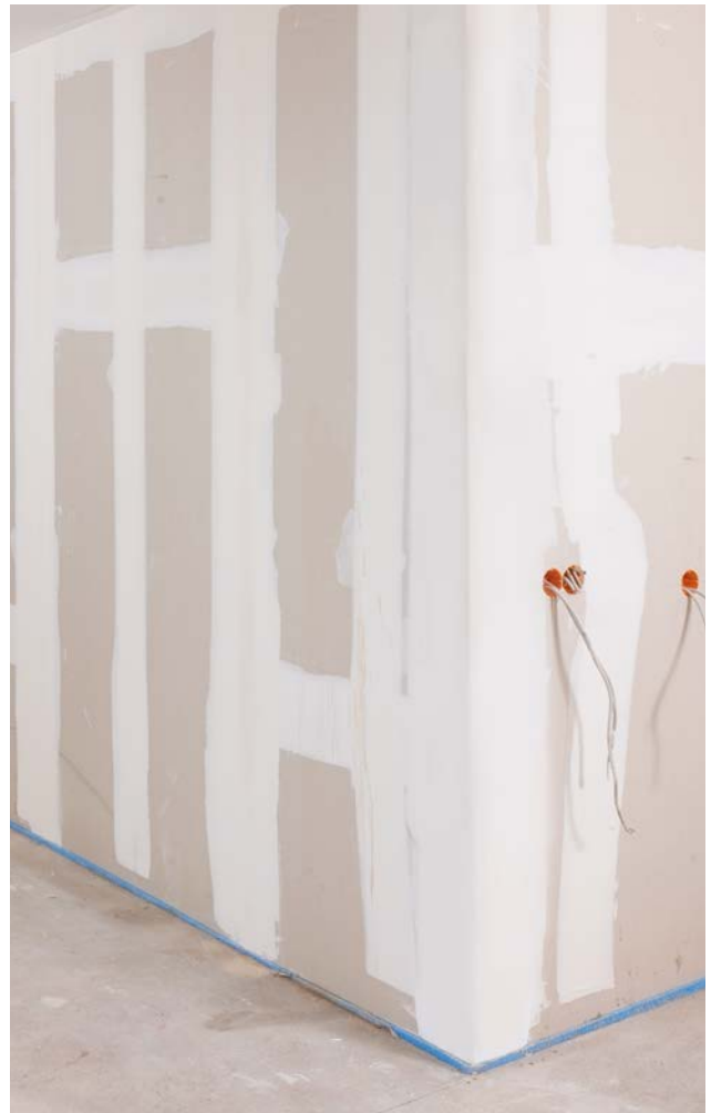
Fertige Außenkante mit dem flexiblen Kantenschutz Rigips AquaBead Flex PRO.
