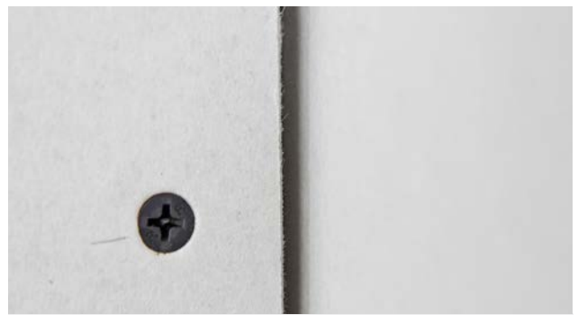
Linke Platte: gefaste Kante an Rechte Platte: VARIO-Kante
