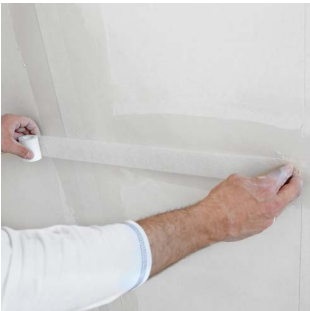
Der Rigips Glasfaserbewehrungsstreifen wird auf den VARIO Fugenspachtel aufgelegt. Im Anschlussbereich der Längs- und Quertugen darf es zu keiner Überlappung der Glasfaserbewehrungsstreifen kommen.
