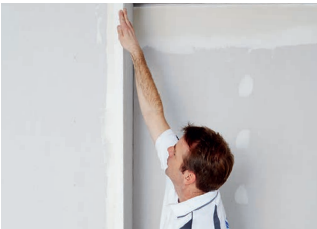
Ausrichten des Rigips Levelline.
