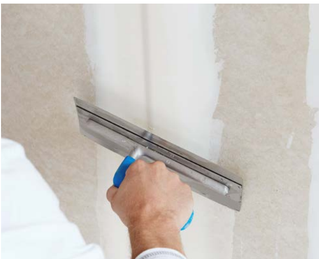
Zur Erzielung einer perfekten Wandoberfläche erfolgt die Nachspachtelung ebenfalls mit VARIO Fugenspachtel.
