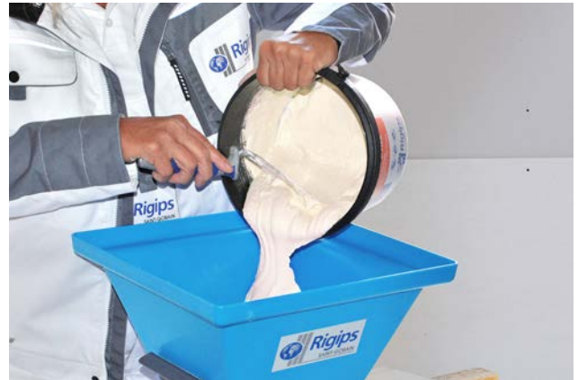
... und dann in den Rigips Auftragsbehälter eingefüllt.
