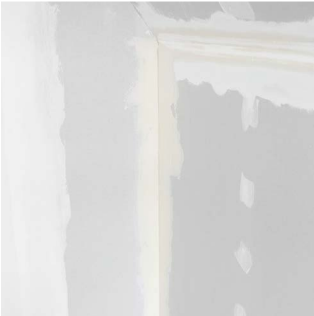
Ausdrücken der Ecken und Vorlegen des Spachtelmaterials.
