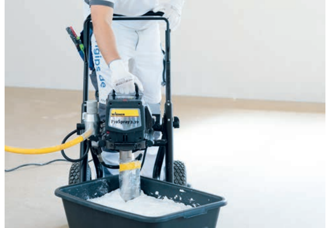
Airless Ansaugrohr in die Masse tauchen
