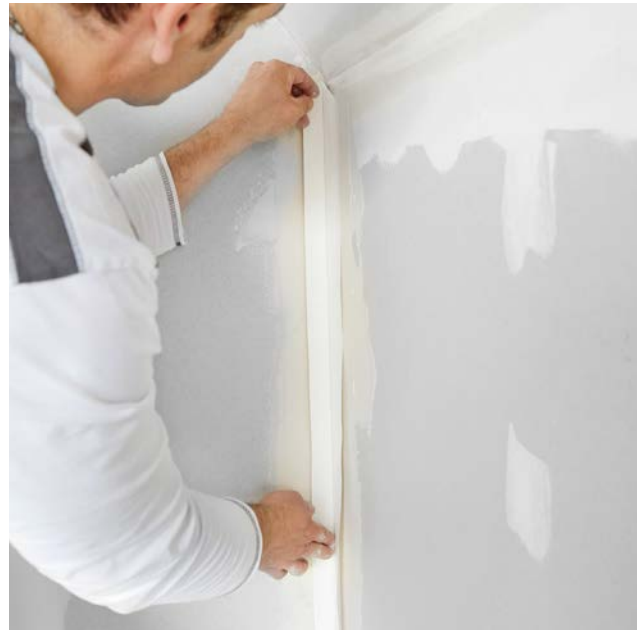
Einlegen des Rigips Levelline im Eckbereich.
