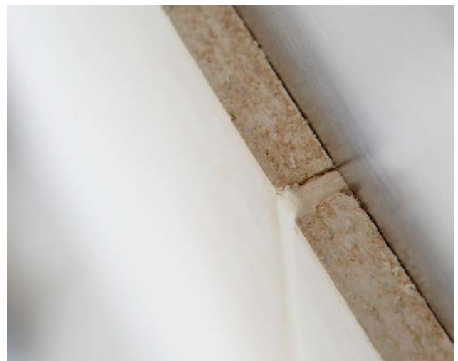
Komplett ausgefüllte Spachtelfuge (von oben) mit planebenem Ergebnis.
