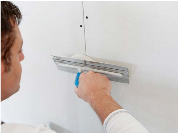
Die Längskante mit SUPER Fugenfüller ausspachteln.
