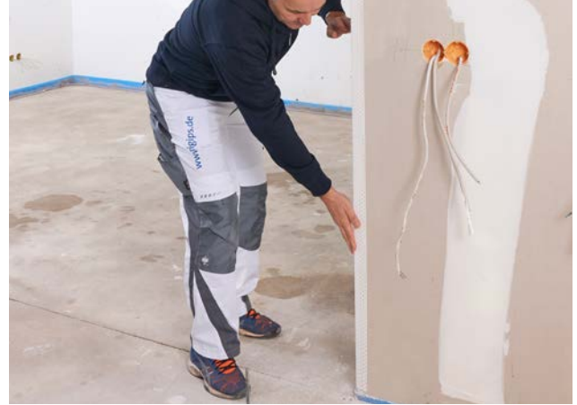
Ansetzen des AquaBead Flex PRO und Andrücken per Hand von oben nach unten.
