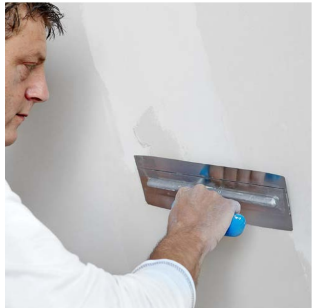
Spachtelmaterial bis auf „null“ ausziehen.
