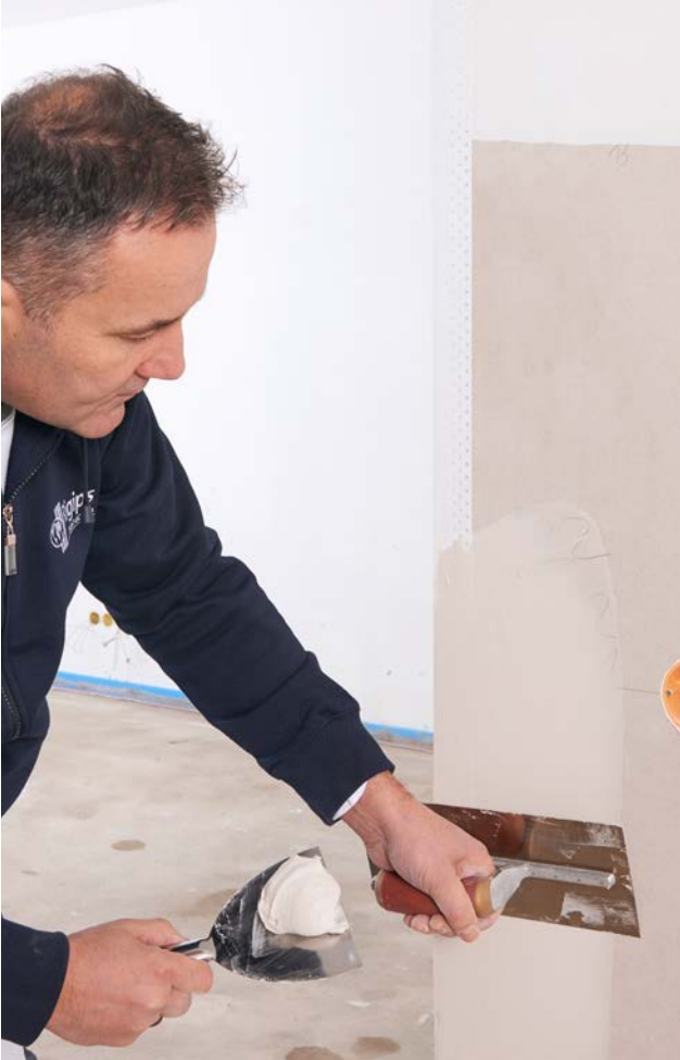
Nach ca. 20 Minuten kann die Ecke mit VARIO Fugenspachtel vorgespachtelt werden.
