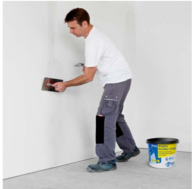
Danach das Fugenfinish mit ProMix Finish durchführen.
