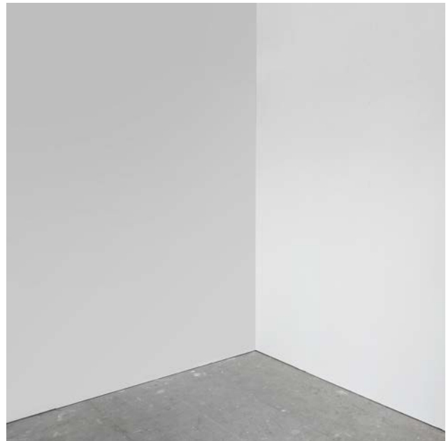
Überzeugendes Resultat: eine makellose weiße Oberfläche. Die technische Fugenverspachtelung wurde komplett mit VARIO Fugenspachtel vorgenommen und die Q3-Qualität dann mit dem ProMix Finish vollendet.
