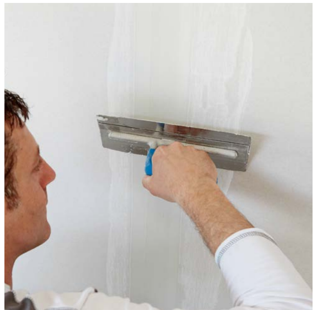
Überziehen des Glasfaserbewehrungsstreifens ohne zusätzlichen Materialauftrag.
