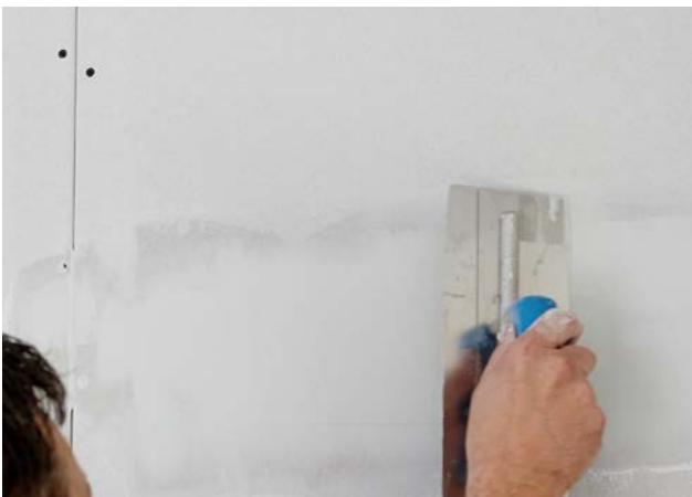
Überziehen des Glasfaserbewehrungsstreifens ohne zusätzlichen Materialauftrag.
