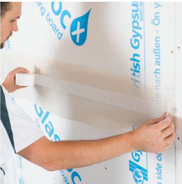
... und unmittelbares Einlegen des Rigips Glasfaserbewehrungsstreifens.
