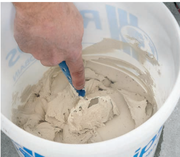
Ca. 3 Minuten Sumpfzeit beachten und das Material danach klumpenfrei verrühren.
