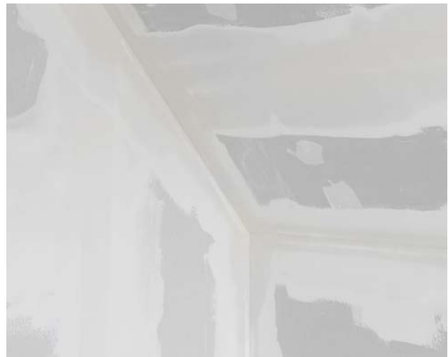
Fertige Dachgeschossituation mit Rigips Levelline mit unterschiedlichen Winkelstellungen.
