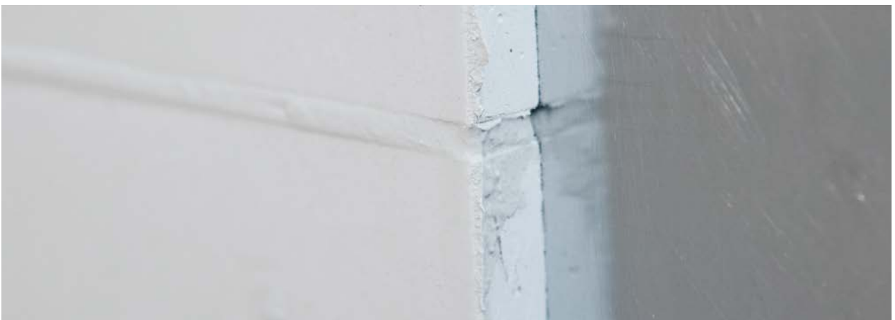
Auf das vollständige Füllen der Fugen ist zu achten!
