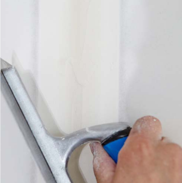
Ebenheit prüfen und evtl. Spachtelgrate mit dem Kellenrücken abstoßen.
