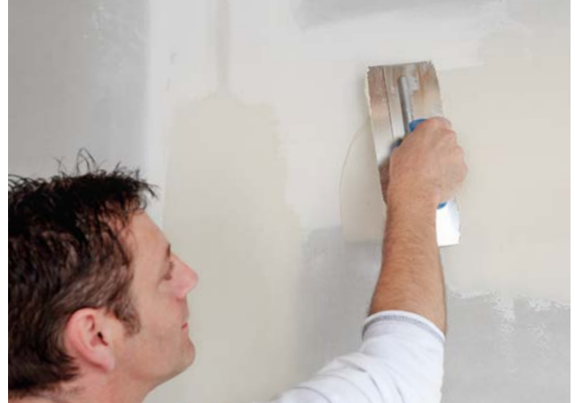
... erfolgt die Nachspachtelung bei den Quer- und Längsfugen.
