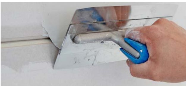
Ausdrücken der Querfugen mit SUPER Fugenfüller.
