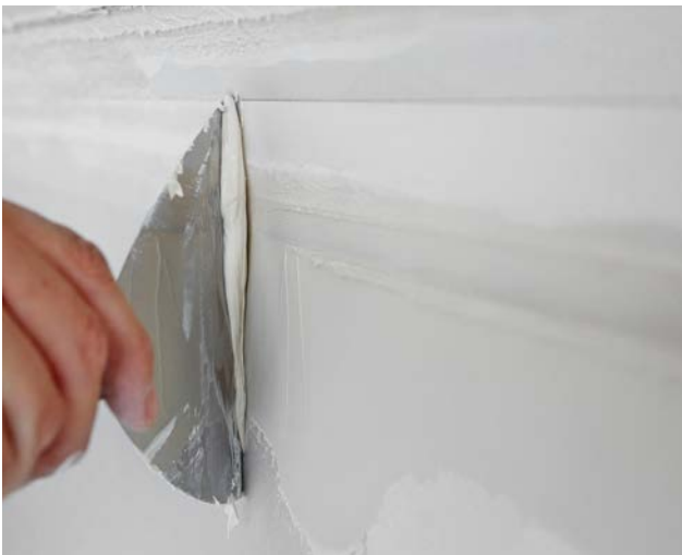
Abziehen des überschüssigen Fugenspachtels.
