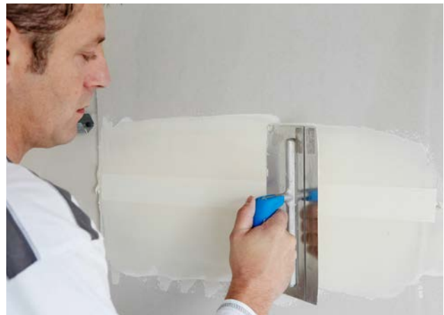
Einbetten des Rigips Papierbewehrungsstreifens ohne zusätzlichen Materialauftrag.
