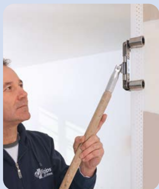
Anpressen mit dem Kantenroller, bei der Außenecke - wie hier gezeigt - mit dem Rigips Außenkantenroller für 90°- Winkel...
