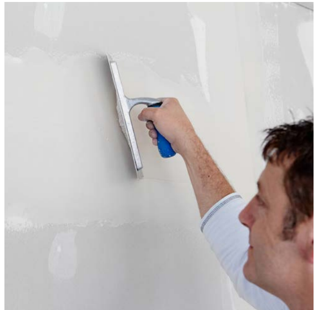
Zum Schluss wird mit nahezu anliegender Kelle mit einem geraden und schnellen Zug die Nachspachtelung mit den Quer- und Längsfugen geglättet. Mit dieser Nachspachtelung ist dann die Qualitätsstufe Q2 erreicht.
