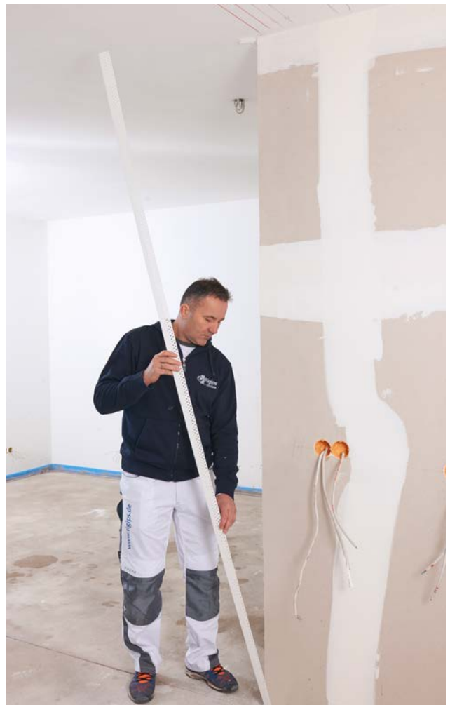
Ansetzen des Rigips AquaBead Flex PRO auf die Eckausbildung.
