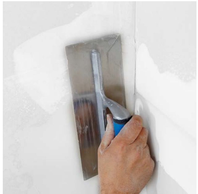
Vorlegen des Spachtelbettes.
