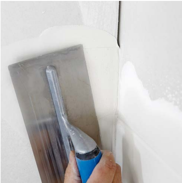
Fugenspalt ausdrücken mit Fugenspachtel.
