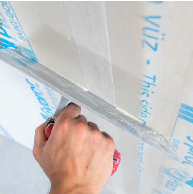
Das Überziehen des Rigips Glasfaserbewehrungsstreifens erfolgt ohne zusätzlichen Materialauftrag.
