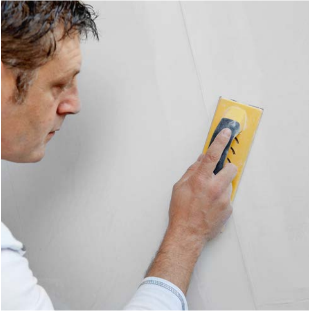
Sobald das Spachtelmaterial der Vorspachtelung abgebunden ist, können evtl. Spachtelgrate abgeschliffen werden, damit der nächste Spachtelvorgang erfolgen kann.
