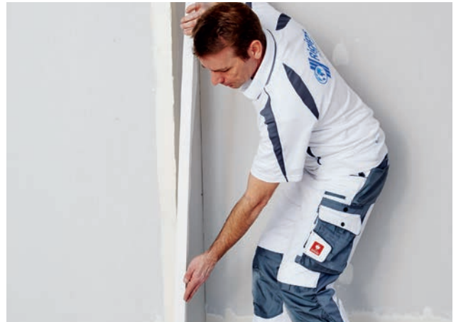
Ansetzen des Rigips Levelline.
