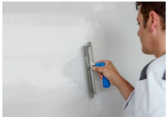
Mit der Nachspachtelung erreicht man den stufenlosen Übergang zur Plattenoberfläche.
