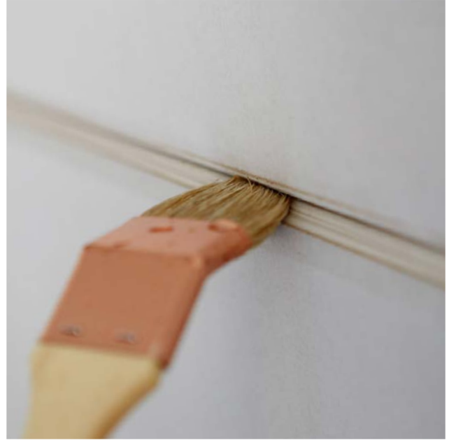
Das Vornässen der Querkanten ist wichtig, damit der Spachtelmasse nicht zu schnell das Wasser entzogen wird.
