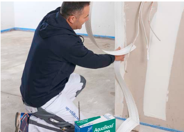
Das Abmessen erfolgt direkt an der gesamten Kanten- ausbildung. Markierung der fertigen Länge per Hand oder Einzeichnung.
