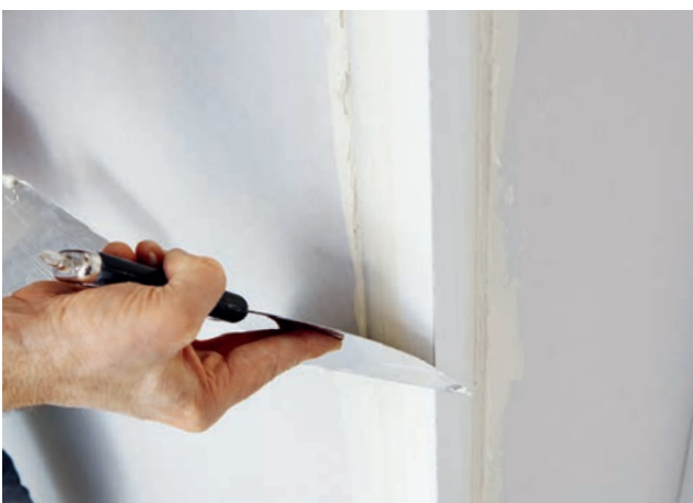
Überflüssige Spachtelmasse wegnehmen und den Rest ausziehen.
