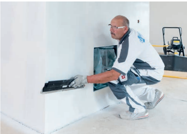
Die frisch aufgetragene Spachtelmasse mit einem Flächenspachtel glatt abziehen und vollständig trocknen lassen.
