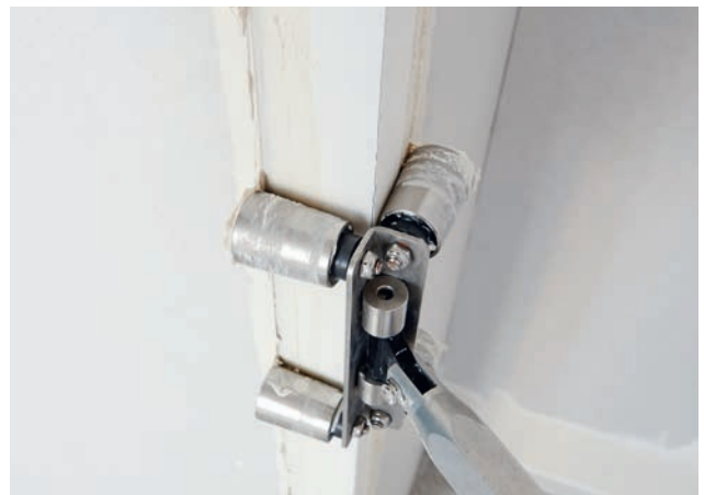
Anpressen mit dem Rigips Außenkantenroller.
