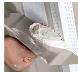
Applied AquaBead edge protection
