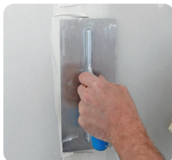
Ausdrücken und blasenfreies Verfüllen
