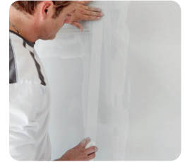
Spachteln mit Rigips Bewehrungsstreifen
