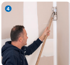
Innenkante mit dem Rigips Innenkantenroller
