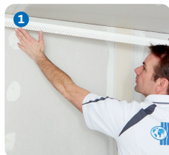
Abschlusskante ausrichten
