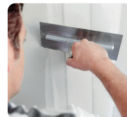
Spachteln ohne Rigips Bewehrungsstreifen
