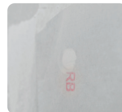
Die Verspachtelung des Schraubenkopfes ist problemlos in einem Arbeitsgang möglich
