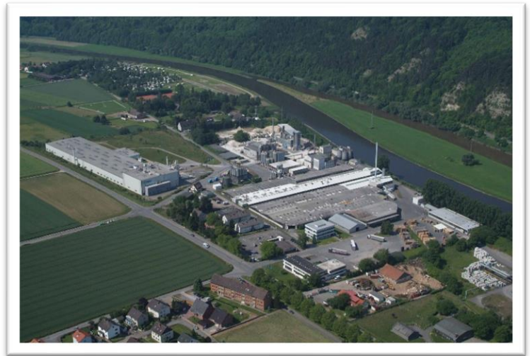
Abb. 1: Das Rigidur Gipsfaserplattenwerk
