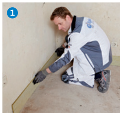
Laying edge insulation
