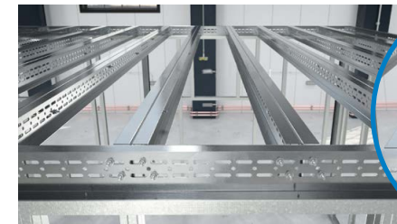
Einbau der UA-Tragprofile in der Decke (Decke ist begehbar) mit Anschluss an Rähm
