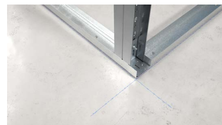
Stellung der UA-Profile mit Verankerung am Boden
