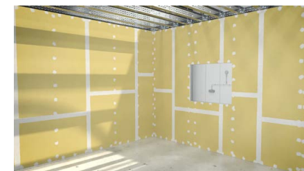
Montage der innerseitigen Bekleidung
