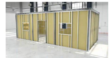
Einbau des Dämmstoffs bei Bedarf in Wand und Decke
