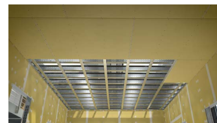
Montage der Tragprofile und der unterseitigen Deckenbekleidung
