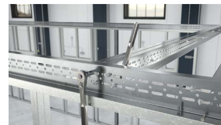
Anschluss der Deckenprofile an umlaufenden Rähm
