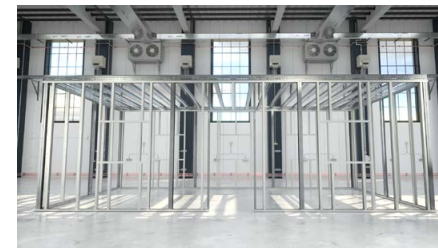
Einbau der Wandprofile (RigiProfil MultiTec CW unter Beachtung von Öffnungen)
